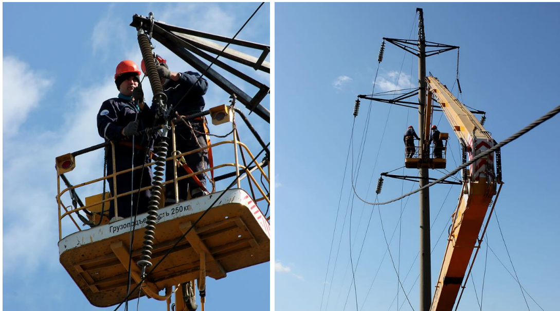
Рисунок – 1.1. Реконструкция электрических сетей
